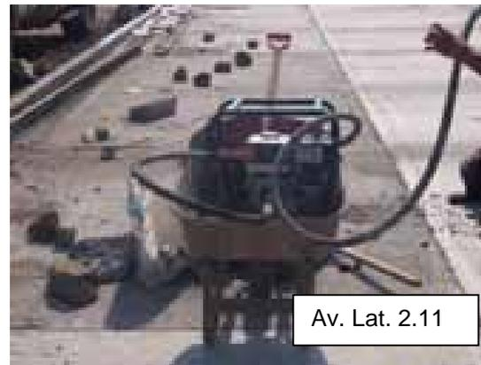
**Foto 2.11.** Vibrados sumergible.
