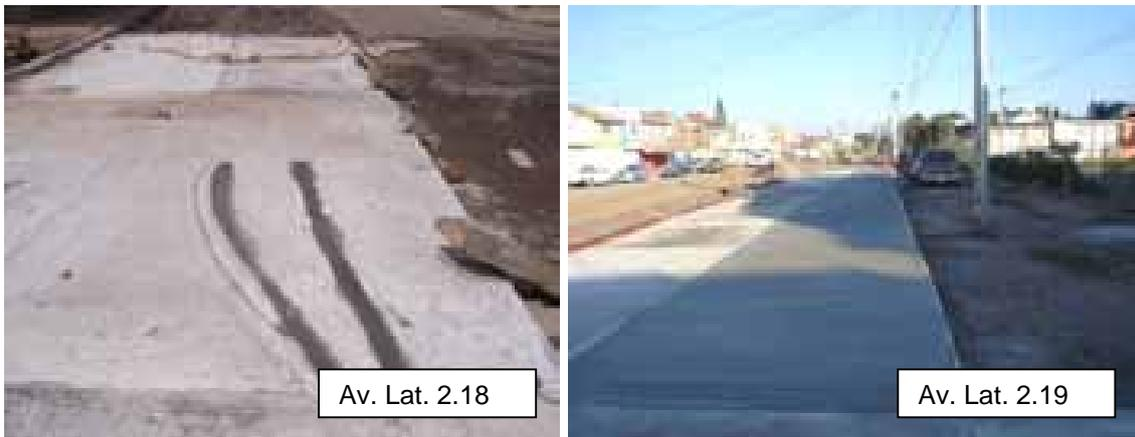
**Foto 2.18 y 2.19.** El texturizado del pavimento fue destruido por no proteger la zona de trabajo con barreras para evitar el paso de las personas, en la imagen de la derecha se observa que no se tiene la preocupación por proteger el concreto fresco.
