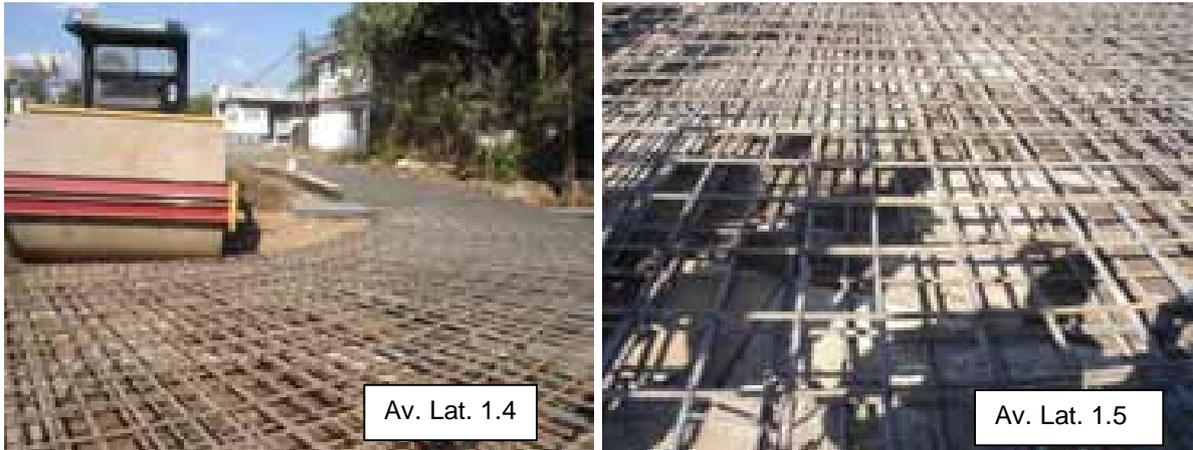
**Foto 1.4 y 1.5.** Acero de refuerzo en encofrado de canal que atraviesa a la Avenida Latinoamericana de de la ciudad de Uruapan.
