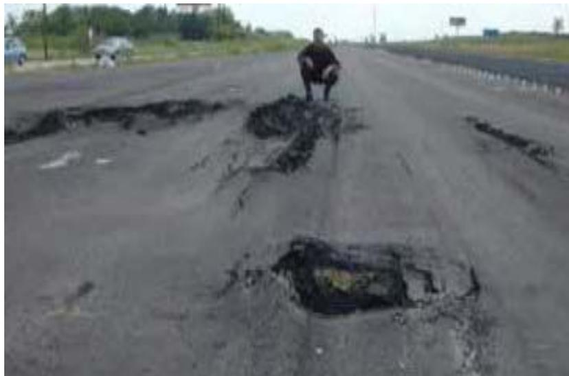
**Foto 1.1** Ejemplo extremo de fracaso de un pavimento por suelos inestables. Independientemente del tipo de pavimento que se tenga. (www.lime.org;2006)
