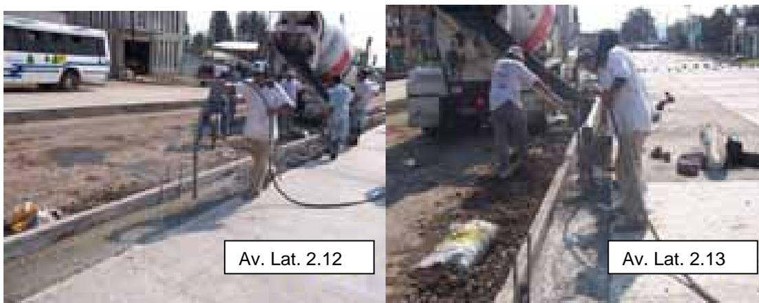
**Foto 2.12 y 2.13** Operando un vibrador desde la forma en que se sostiene hasta la manera en que éste es sumergido al concreto.
