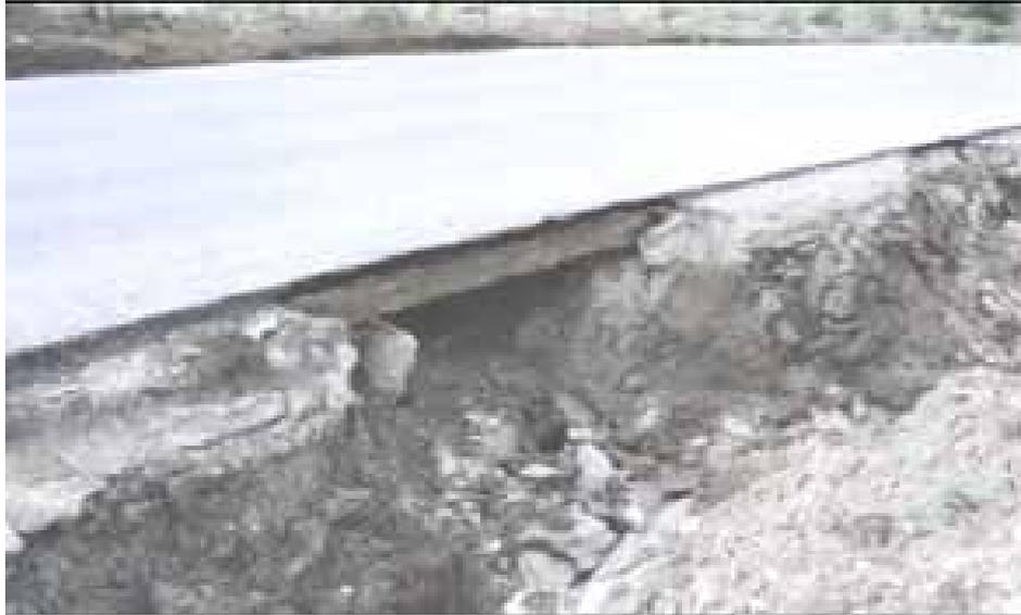
**Foto 1.3** La capa estabilizada con cal soporta la erosión, ilustrando la resistencia. (www.lime.org;2006)
