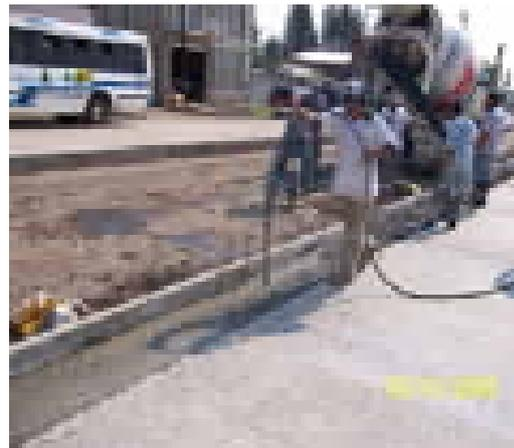
Foto 4.17 y 4.18 Muestreos de concreto en obra, colocación y vibrado del concreto.
