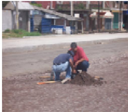
**Foto 4.11 y 4.12** Estudio de material, grado de compactación y humedad óptima.
