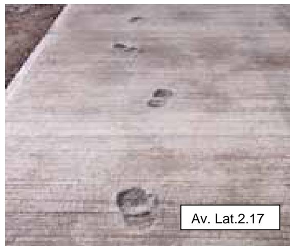
**Foto 2.16 y 2.17.** Texturizado de pavimento fue destruido por condiciones climatológicas ya que este no fue protegido con plásticos, de la misma manera no se colocaron barreras para impedir el paso de las personas.
