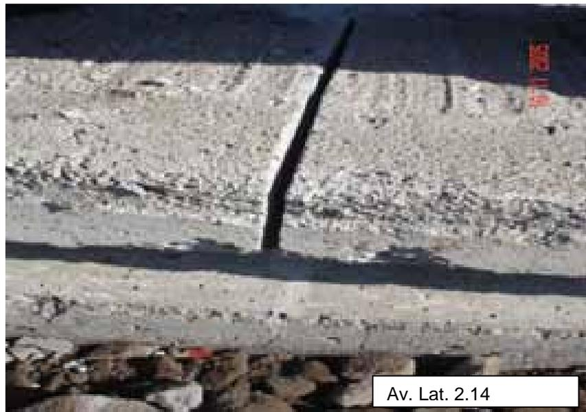
**Foto 2.14.** Se observa el corte que se realiza a la losa de concreto Cumpliendo con lo que marca el proyecto.
