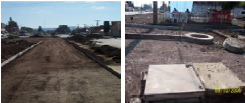
Foto 4.15 y 4.16 Grado de compactación aceptable, superficie limpia y humedad optima.
