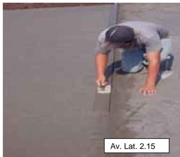
**Foto 2.15** Texturizado para la superficie de rodamiento con cepillo de dientes acerados.
