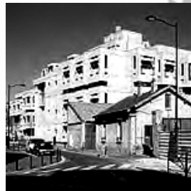
Vista del edificio previa a la remodelación
