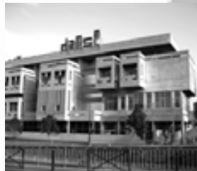
La fachada después de la rehabilitación
