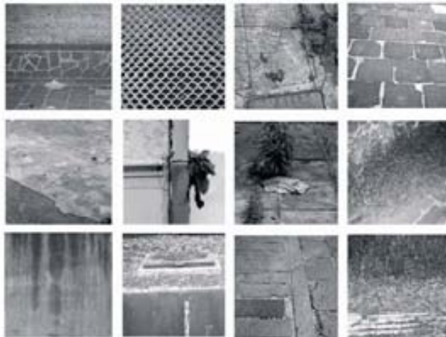
Pavimentos y materiales en muros y pisos existentes
