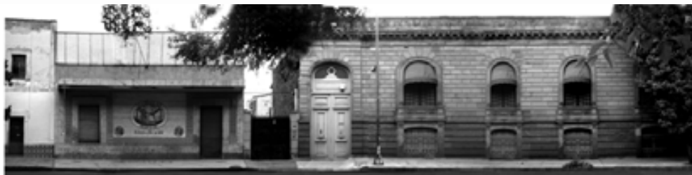
Larguillo de la fachada principal, Calle de Cedro
