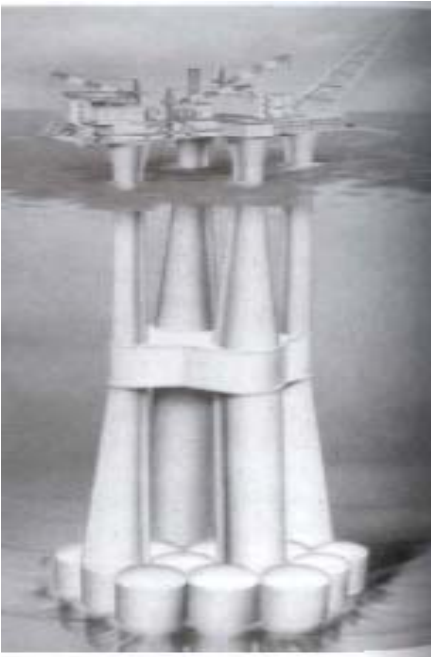
FIG. II.2 PLATAFORMA DE CONCRETO.
