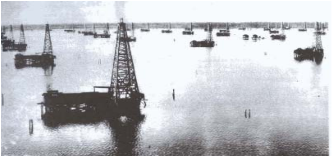
FIG. I.2 PLATAFORMAS SOBRE PILOTES.
