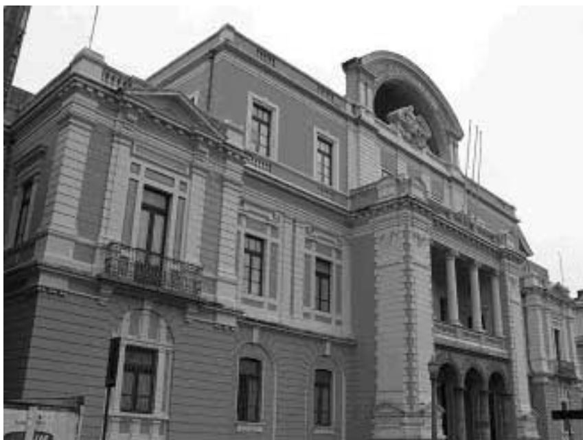
En el tercer piso del edificio de SEP fue instalada la estación radiodifusora durante el mes de noviembre de 1924. Foto de Internet.
