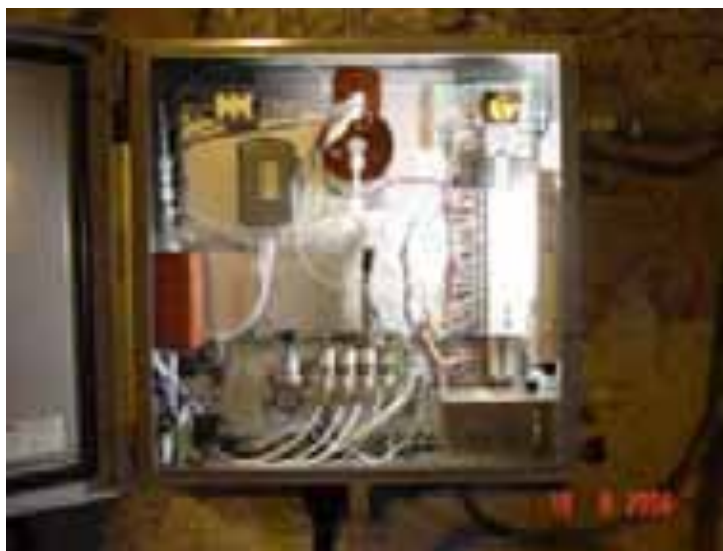
Figura 3.11. Analizador de oxígeno en chimenea
