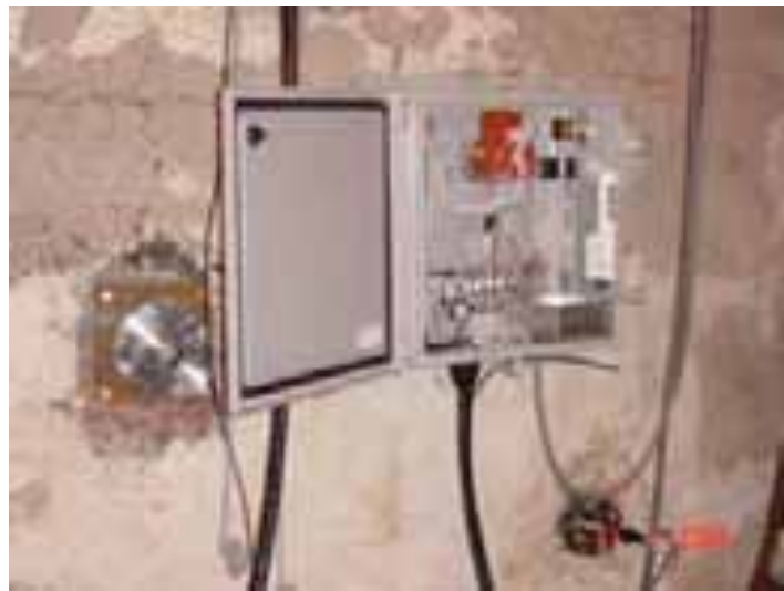
Figura 3.2. Instalación del transmisor de temperatura
