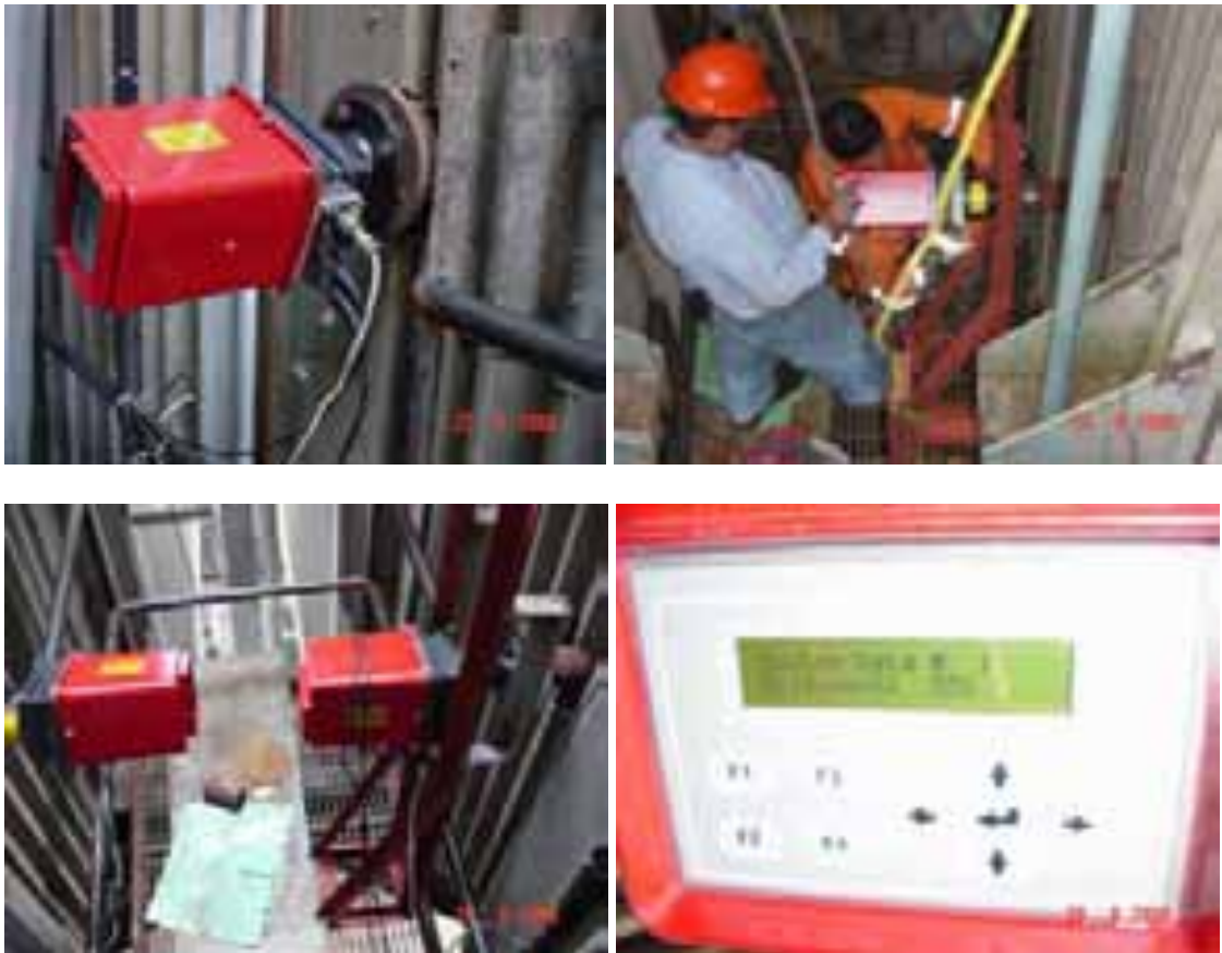
Figura 3.13. Instalación de los analizadores de CO
