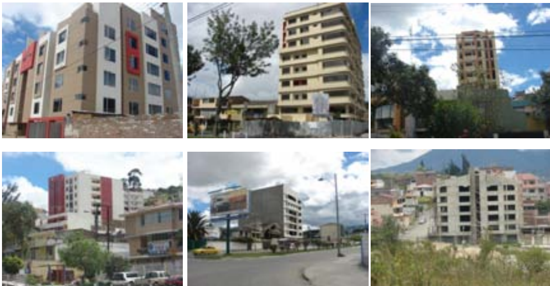
Imagen 33 Ejemplos de edificios de reciente construcción, diseñados para vivienda. Foto: Silvia Viñán, septiembre 2007
