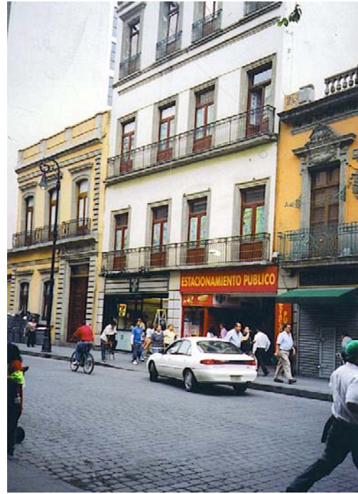
Después de la intervención
