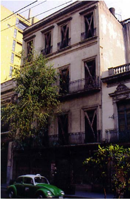
Antes de la intervención
