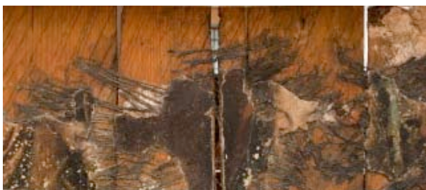
Fig. 6 Detalle de la superficie de las tablas y fragmentos de pintura conservados. Fotografía: Eumelia Hernández, 2008
