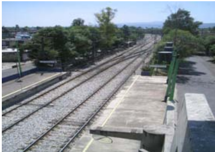
Fotografía 5. Vía sobre Balasto
