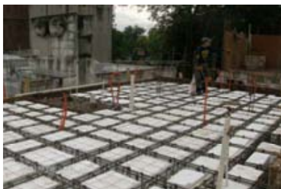
Fotografía 9. Colocación de bovedillas de poliestireno en losa aligerada
