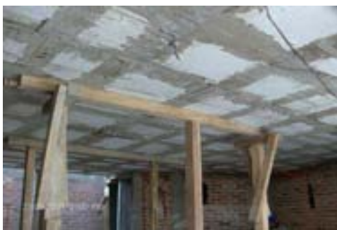
Fotografía 7. Losa aligerada con nervaduras de concreto reforzado
