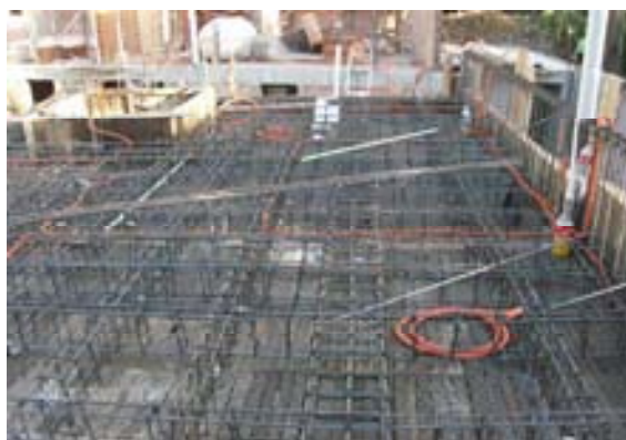
Fotografía 8. Armado de nervaduras de losa aligerada
