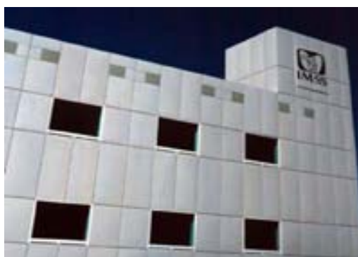
Figura 12. Fachada Hospital IMSS con muros de Porcewol
