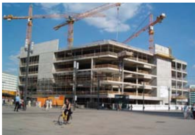
Imagen 37. El edificio en construcción de Die Mitte. Fotografía tomada por la autora en junio de 2008.
