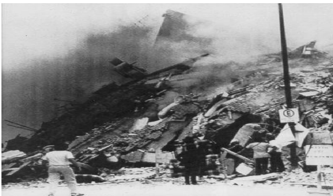
Figura 1.– Edificio derrumbado y humeante en la calle San Juan de Letrán en el Distrito Federal
