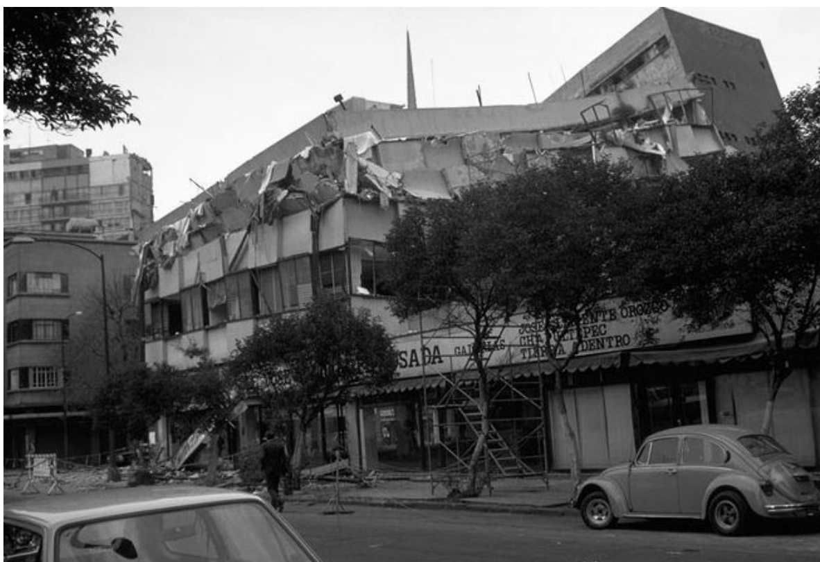
Figura 2.- Daños en edificio de departamentos ubicado en la Zona Rosa del Distrito Federal
