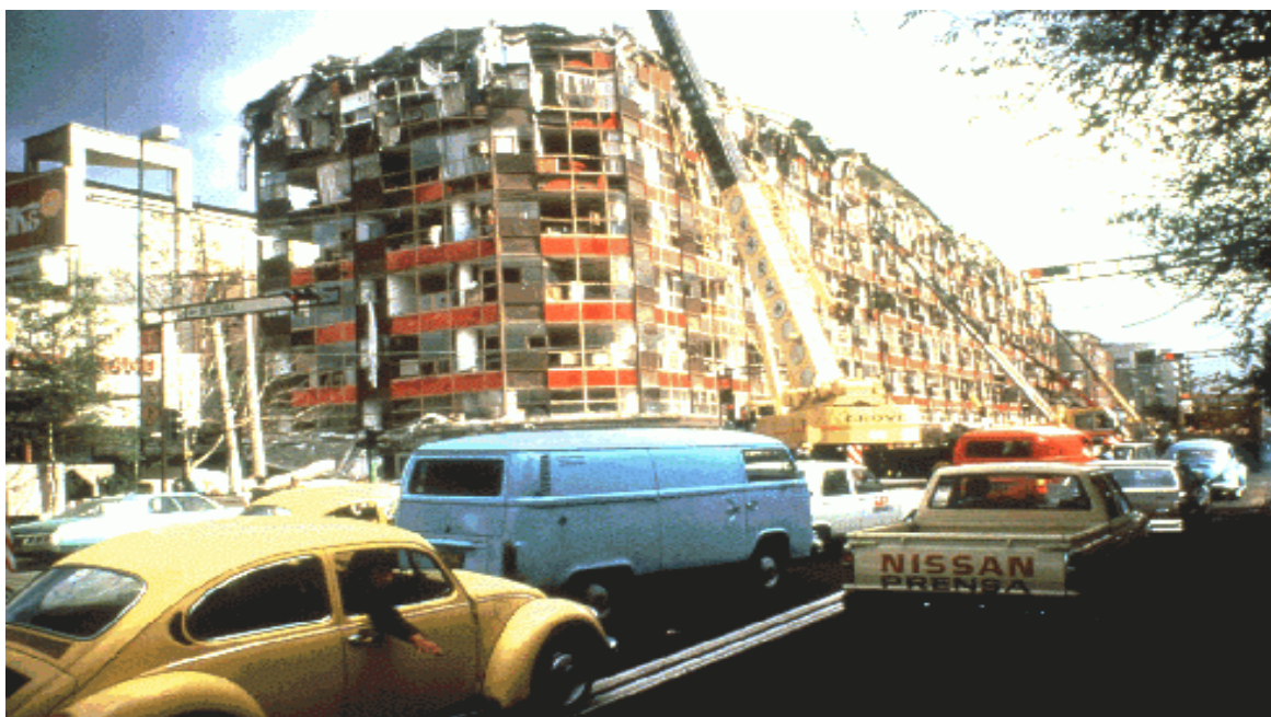
Figura 3.- Colapso del edificio de la Secretaría de Comercio en el Distrito Federal
