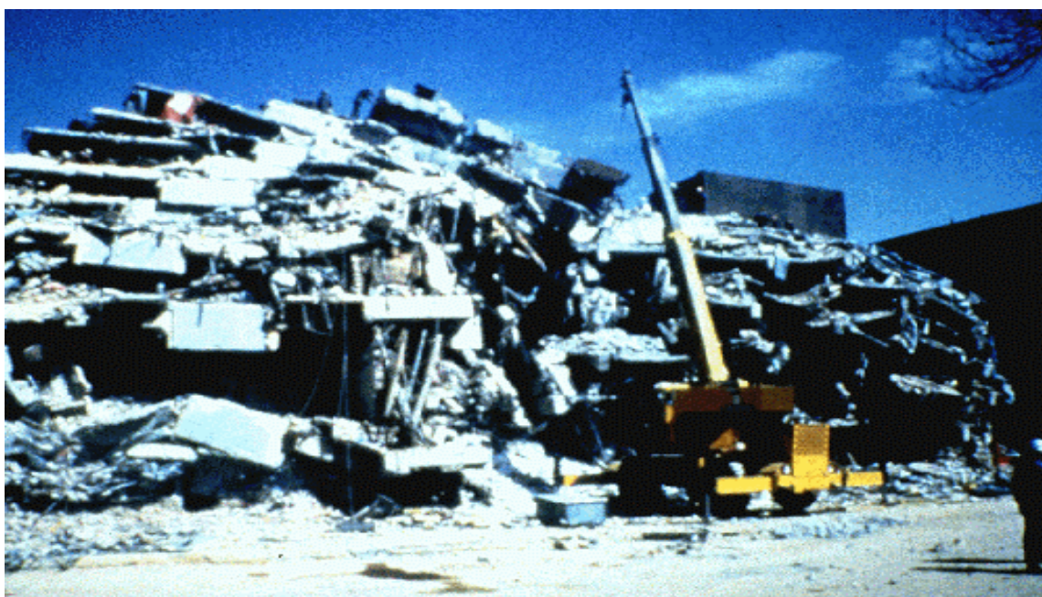
Figura 4.- Colapso total del Hospital Juárez
