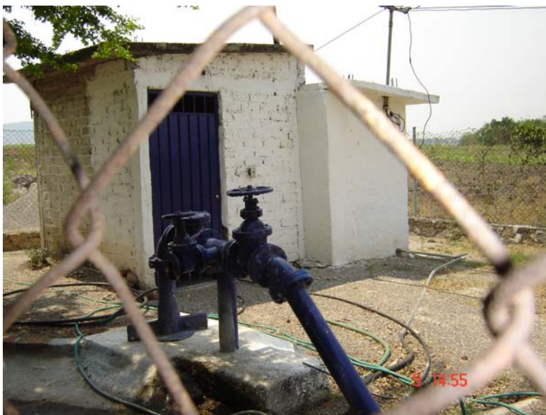
Fig. 4. Vista del pozo Santa María
