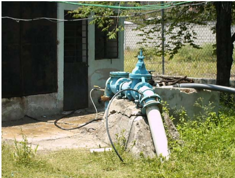
Fig. 16 Vista del pozo Puente Ixtla
