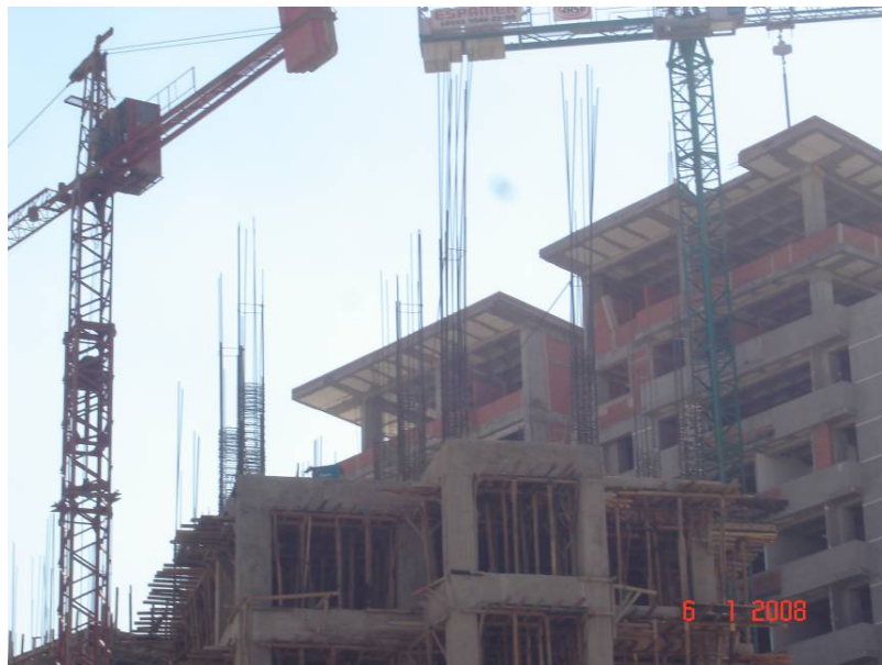
Fotografía 3 Construcción de edificio a base de losa aligerada y muro de block materiales típicos de este tipo de obra
