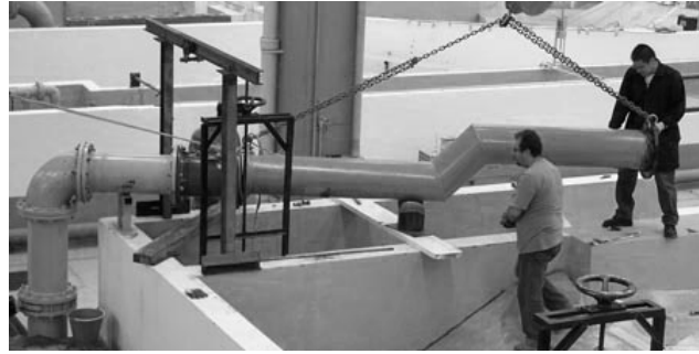
Figura 6.5 Fotografía del armado del tren de descarga.
