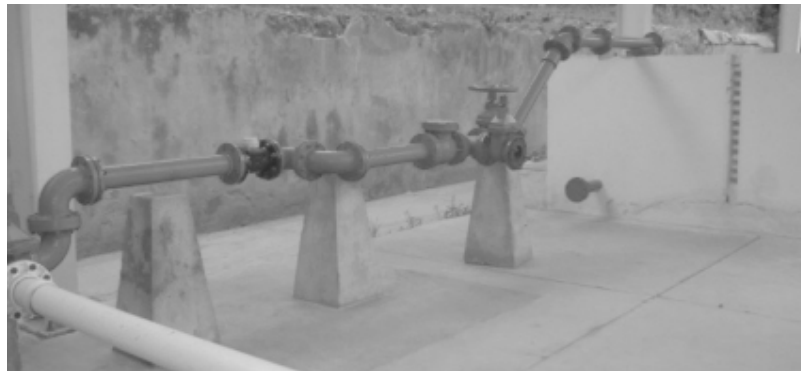
Figura 2.13 Vista del tramo de pruebas.
