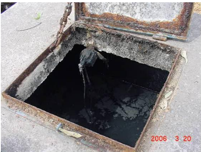
Figura A-4. Tapa del homogenizador o sedimentador primario II
