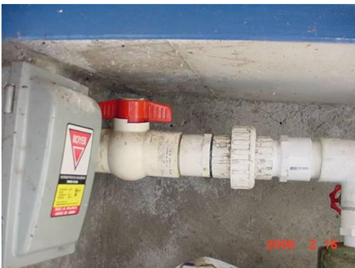
Figura A-7. Válvula de alimentación de alimentación al HAFVD
