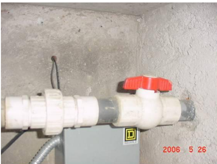
Figura A-5. Válvula de alimentación al HAFVD
