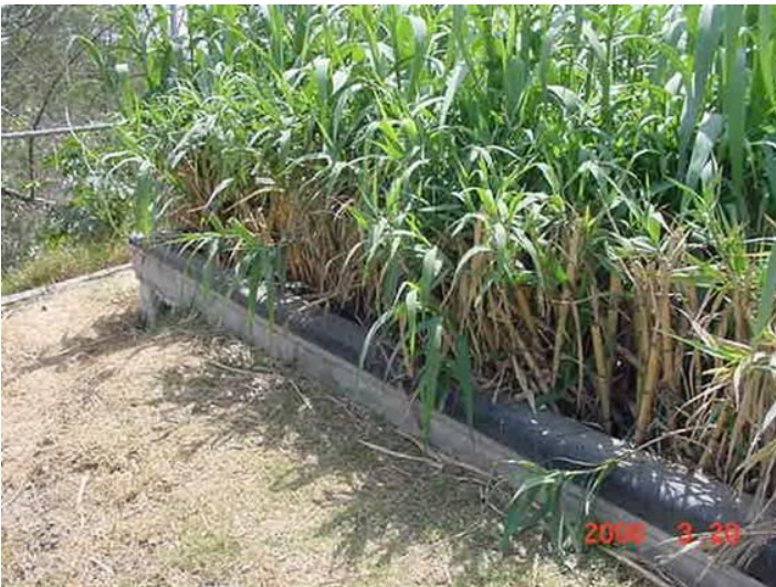
Figura A-10. Acercamiento al HAFVD para ver la geomembrana
