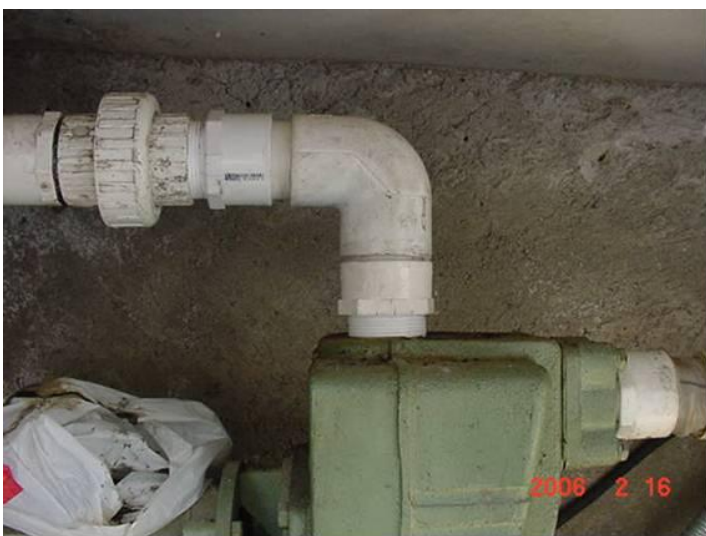
Figura A-6. Bomba de alimentación al HAFVD
