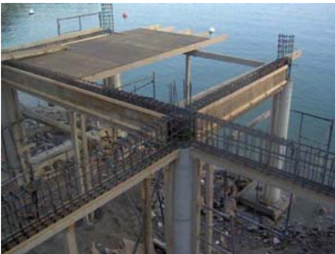
Armado de traves para de losa verde para reciclaje de agua. Propietario Dra. Maria de los Ángeles Fromow R. Apoyo de supervisión de obra. Arq. R.R.R.
