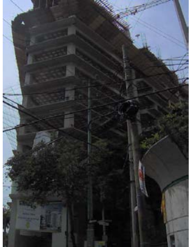
Foto 16 etapa de construcción 29
