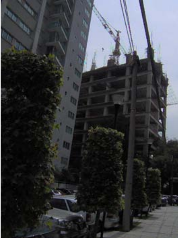
Foto 15 etapa de construcción 28
