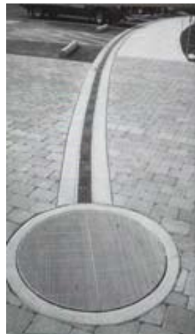
Imagen 26 Captación de aguas pluviales en estacionamiento [47]
