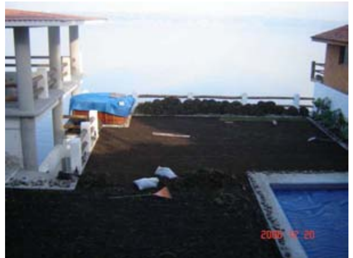
Preparación de losa verde para reciclaje de agua. Propietario Dra. Maria de los Ángeles Fromow R. Apoyo de supervisión de obra. Arq. R.R.R.
