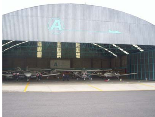
Foto 24. Angares del Aeropuerto
