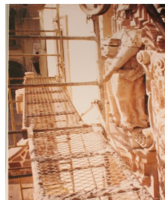
IMAGENES EN RESTAURACIÓN, FACHADA.
