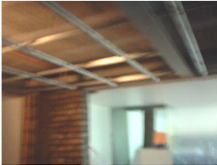
Figura 69 Colocación del techo diseñado acústicamente
