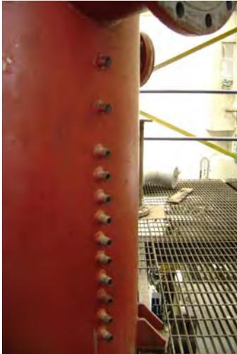
Fig. 3.3 Orificios en el gasificador para las sondas de temperatura
