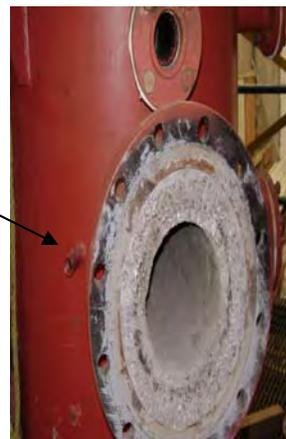
Fig. 3.8 Instalación del sensor de presión
