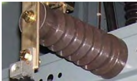
Figura 6. Foto de un aislador de resina epóxica.
