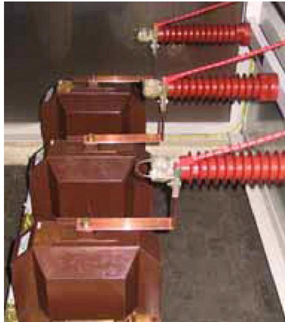
Figura 30. Transformadores de potencial para sistemas de MT.
