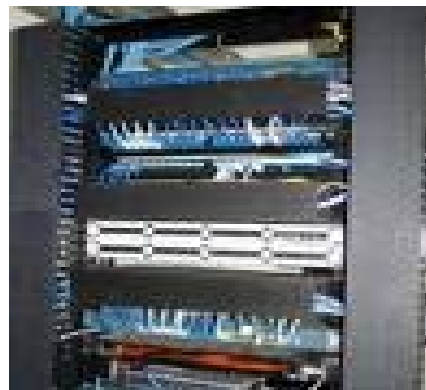
Figura 43 Colocación de los Patch Cord en los Switch
