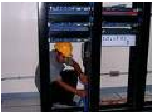
Figura 43 Colocación de los Patch Cord en los Switch
