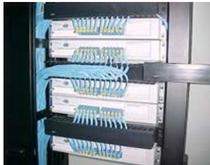
Figura 42 Instalación de los switches
