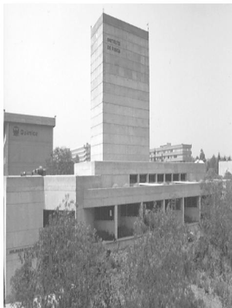
Figura II.1. Edificio del acelerador Van de Graaff de 5.5 MV del IFUNAM
