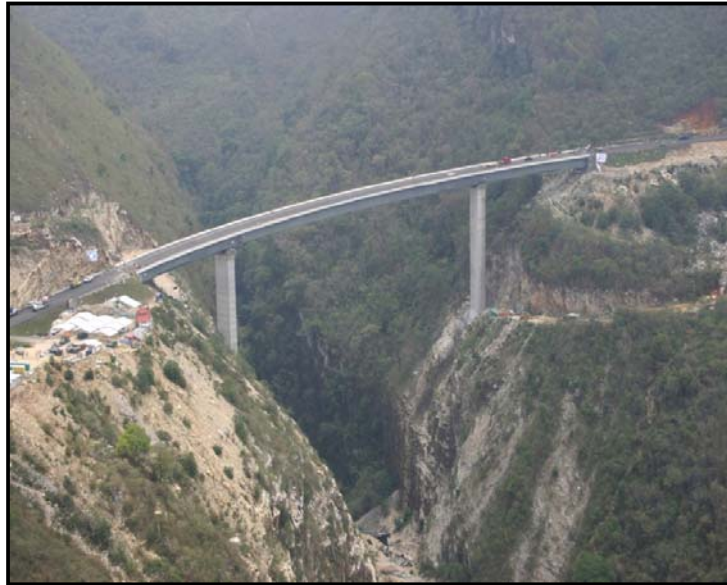
Fig. 1 Puente San Cristóbal
