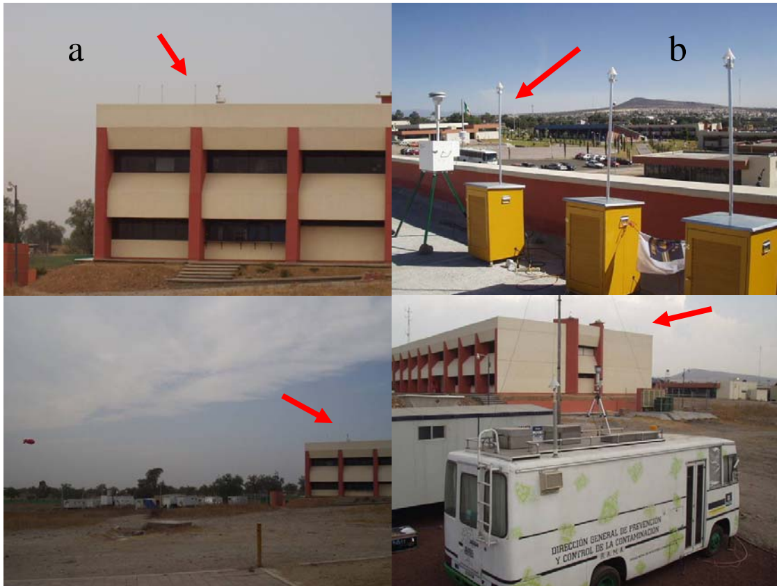
Fig 2.3. Sitio donde se instalaron los equipos de muestreo: a) edificio de comunicaciones de UTTEC, b) protección para los equipos de muestreo.
