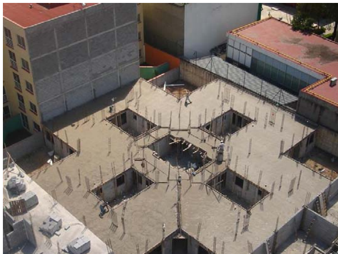
LOSA TAPA DEL PRIMER NIVEL
