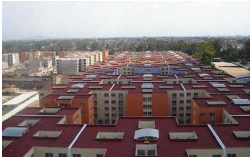
VISTA PANORÁMICA DE LAS LOSAS TAPA DE CADA EDIFICIO
