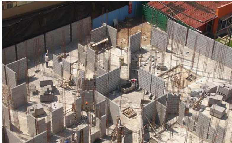
CONSTRUCCIÓN DE MUROS
