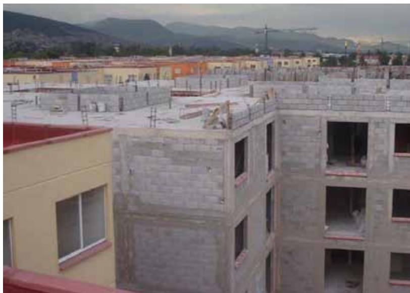
VISTA DE PRETIL TERMINADO Y EN CONSTRUCCIÓN
