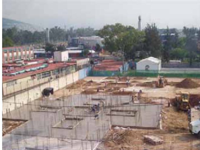
COLADO DE LA LOSA DE CIMENTACIÓN
