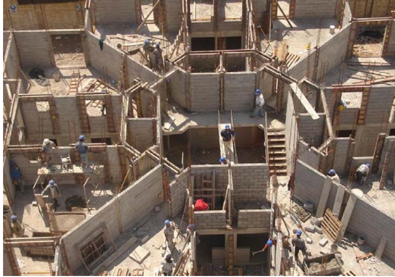
COLOCACIÓN DE CIMBRA PARA COLAR CASTILLOS
