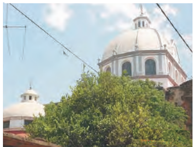
Vista de la cúpulas desde la parte posterior .
