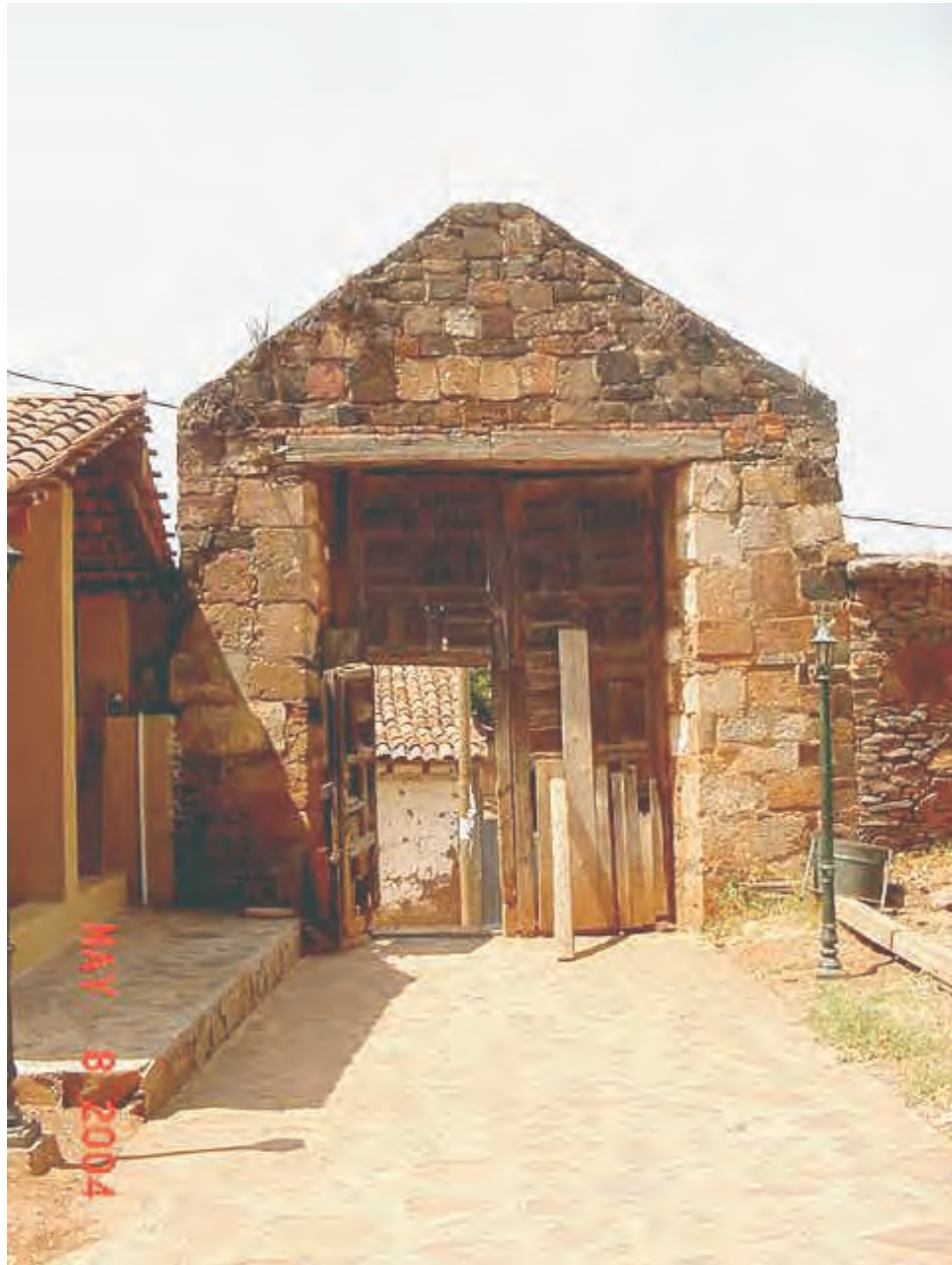
Puerta de acceso a lo que era el hospital. Fotografía: Martha D. Campos C.
