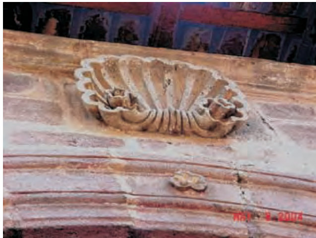
Detalle de una concha en una de las capillas abiertas. Fotografía: Martha Campos C.
