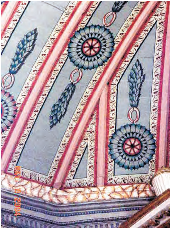
Detalle de la cubierta y sus pinturas.
