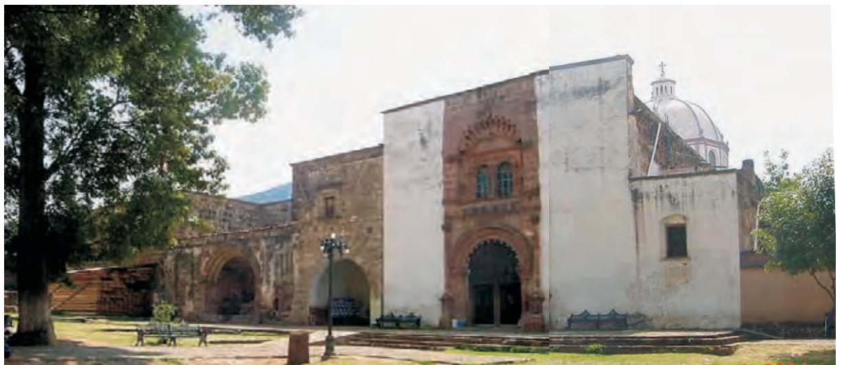
Vista al atrio del conjunto y área de acceso al exconvento en restauración
