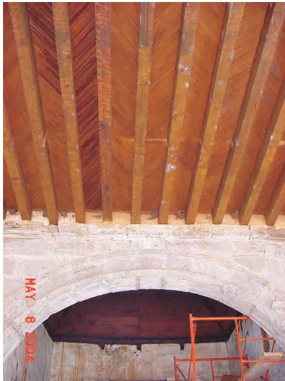
Detalle de los alfarjes en la capilla abierta. Fotografía: Martha Campos C.
