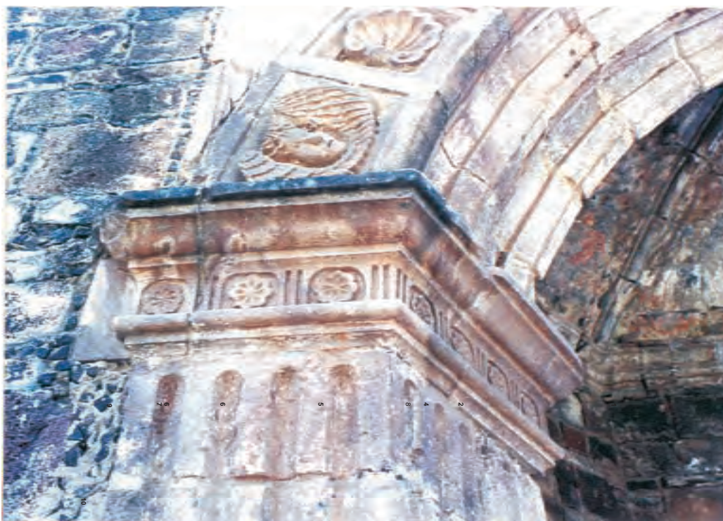
Detalle de los fustes estriados y los casetones en las dovelas en la capilla abierta. Fotografía: Martha Campos
