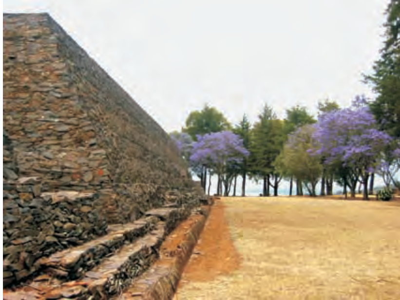
Escaleras intermedias que constituyen la rampa de acceso. Fotografía: Martha Campos.
