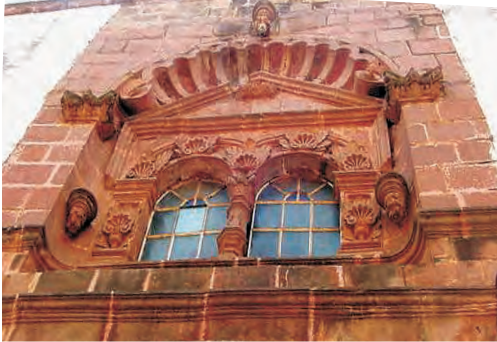
Vista de la concha de la fachada sobre la ventana coral Fotografía. Martha Campos C.
