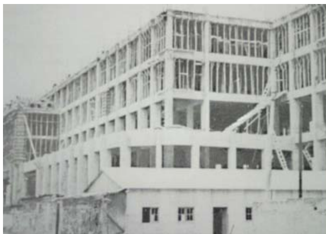
Figura 1.1 Oficinas Generales del IMSS en construcción
