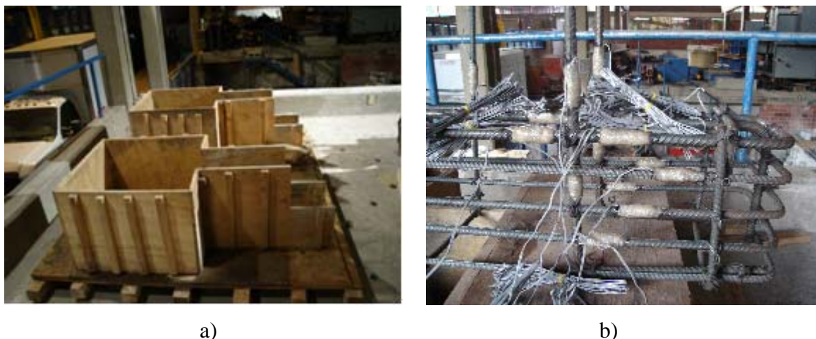
Figura 3.4. Proceso constructivo de los especímenes. a) Cimbra de triplay usada para el colado de los especímenes, montada sobre una plataforma. b) Deformímetros colocados en barras de refuerzo.
