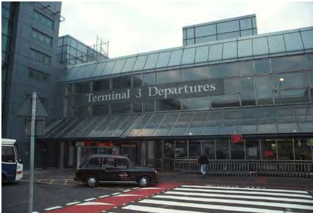
IMAGEN 20. Terminal 3 del Aeropuerto Internacional Heathrow de Londres
