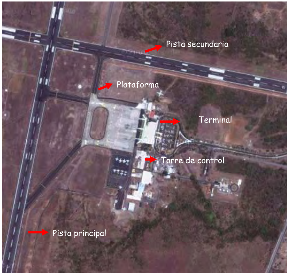
IMAGEN 43. Vista aérea del aeropuerto Internacional Heriberto Jara
