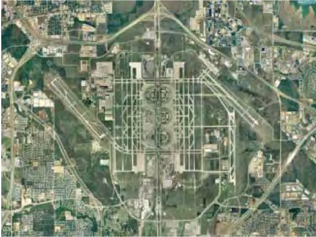
IMAGEN 15. Vista aérea del Aeropuerto de Dallas Fort Worth
