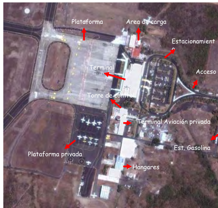
IMAGEN 47. Vista aérea del aeropuerto Internacional Heriberto Jara
