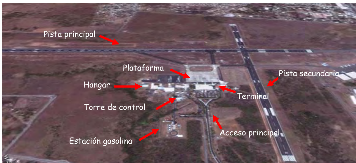
IMAGEN 46. Vista aérea del aeropuerto Internacional Heriberto Jara
