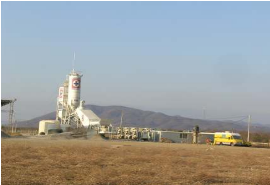
Maquinaria empleada para la excavación e instalación de aerogeneradores
