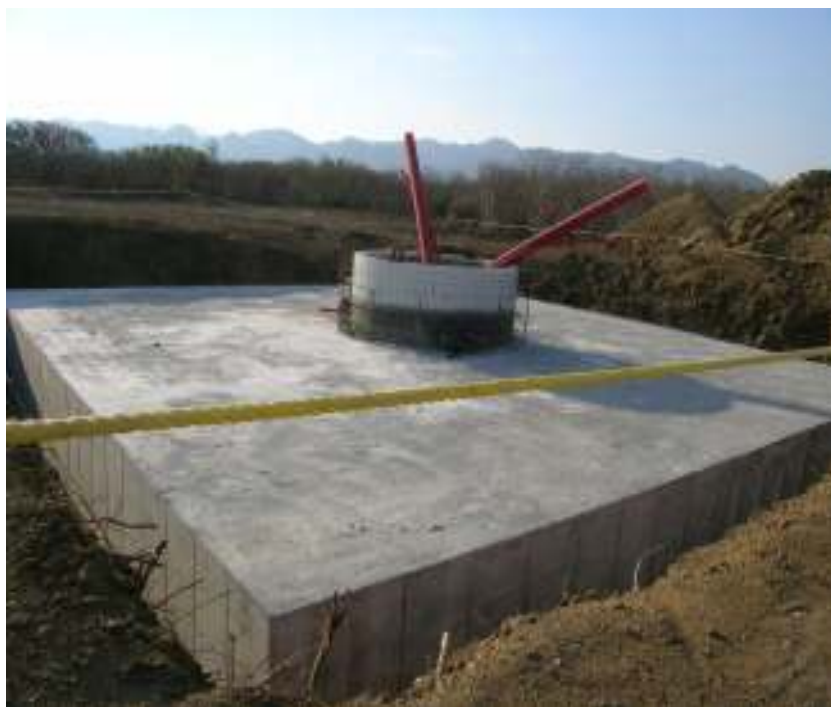
Instalación final de placa de cemento para los aerogeneradores de la Venta II.
