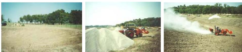
**Impermeabilización del fondo de un estanque (izq) para impedir las filtraciones en profundidad. Al centro, bentonitas para el sellado. A la izquierda, aplicación de las bentonitas en el fondo del estanque.**
