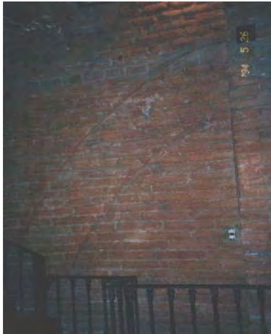
Arco marcado por la rueda vertical en el Molino de Santo Domingo en Tacubaya.
