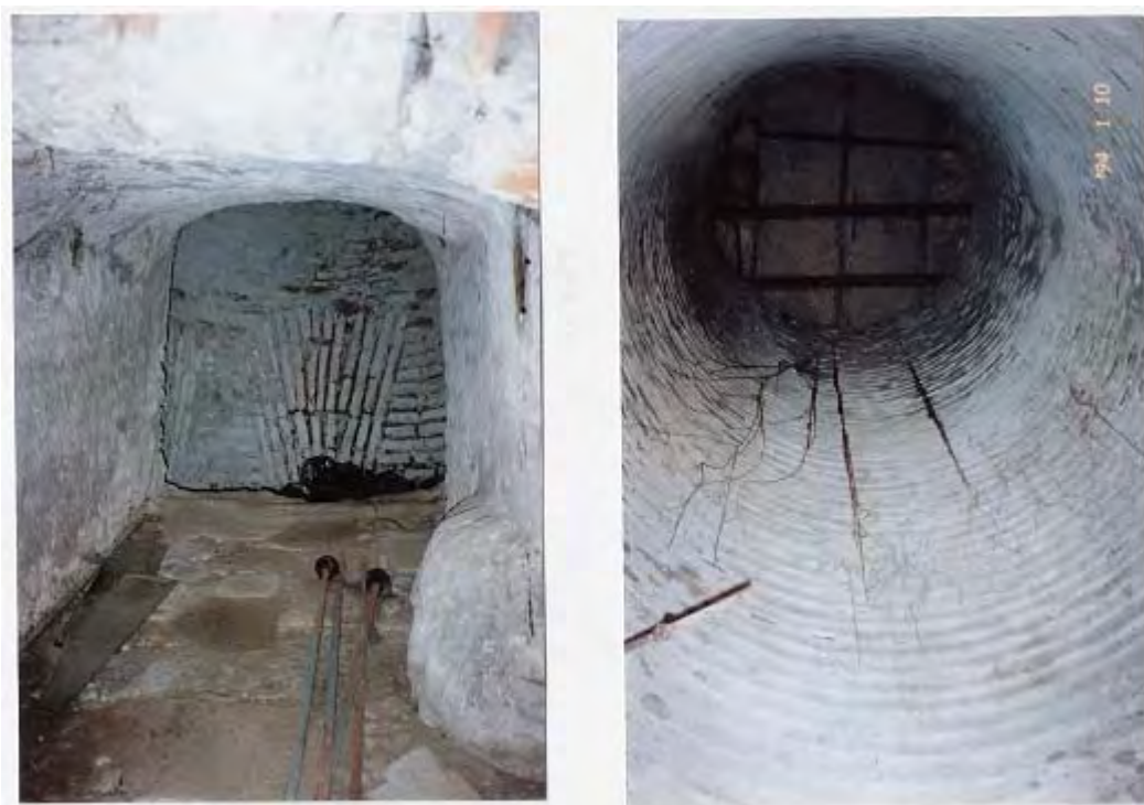
Bocín de mampostería y cubo tapeado del Molino de en medio de San Agustín. (YTT).
