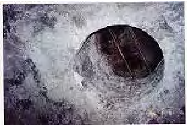
Orificio de la cubierta del cárcavo por donde entra el parahierro.
