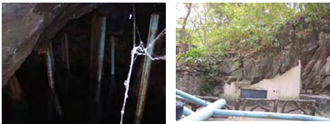
Interior y exterior de la cueva del manantial de las Fuentes Brotantes (2007).
