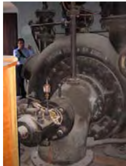
Arcada con el tubo que recibía el agua. Turbina vertical, marca Pelton (YTT).
