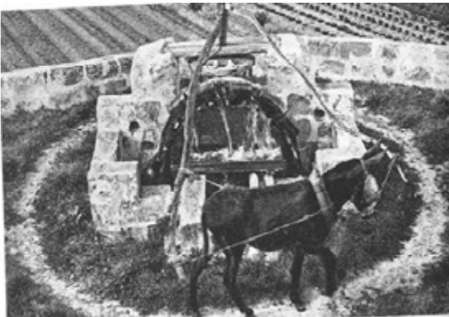
Mecanismo de la antigua Saqiya (noria para extraer agua) 28
