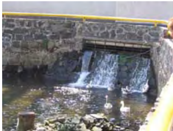
Antigua toma de agua para la fábrica
