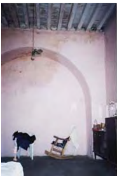
Cubierta del antiguo cuarto del molinero en el molino de en medio.
