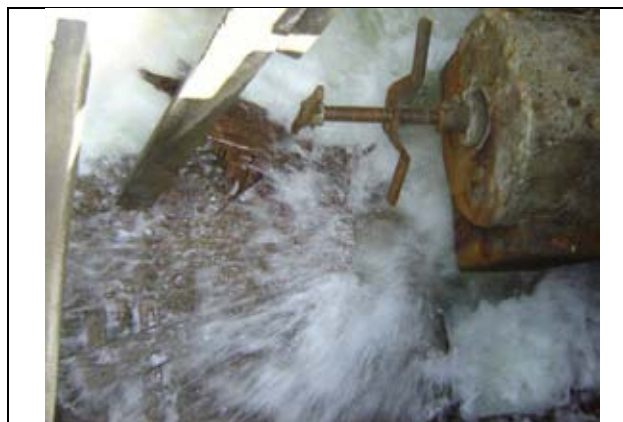
Figura 2.9 Caja de distribución inadecuada
