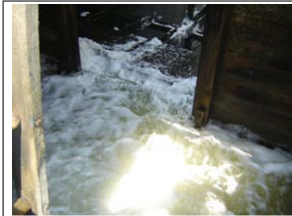
Figura 2.12 Falta pared de la tina de agua caliente.
