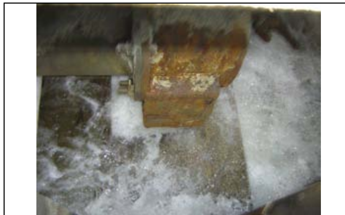
Figura 2.13 Caja de distribución muy pequeña.
