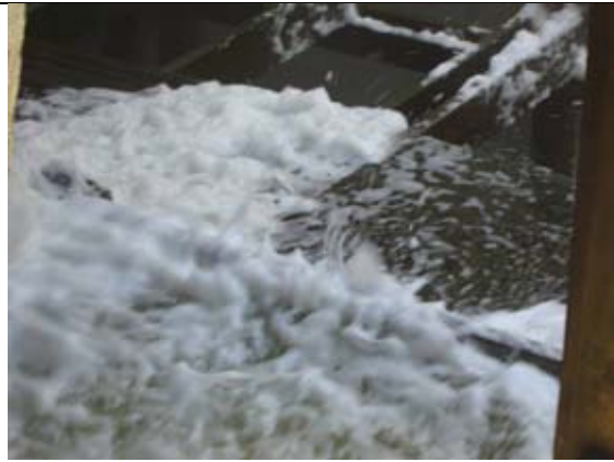
Figura 2.14 Falta pared de la tina de agua caliente.
