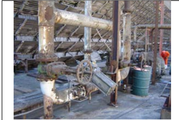
Figura 2.19. Válvula de agua de repuesto.
