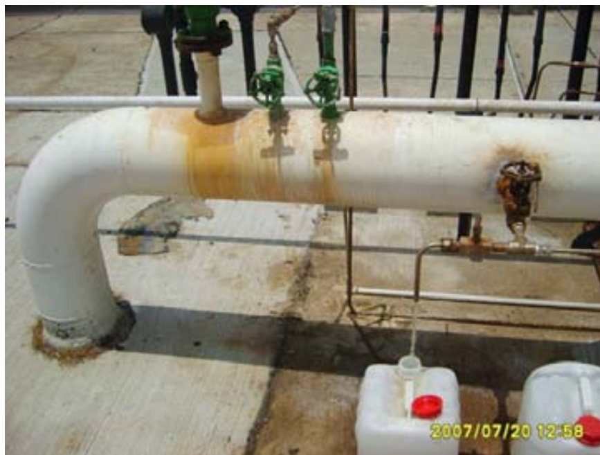
Figura 4.3 Toma de muestra de agua congénita.
