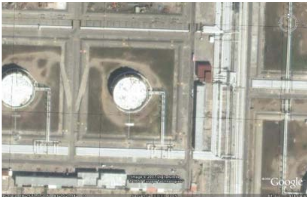
Figura 4.2 Tanque en donde se separa las aguas congénitas del petróleo crudo. www.google.com
