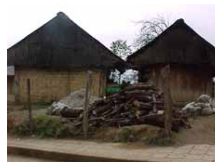
V2.- Con techumbre de madera y teja, muros de adobe y piedra con aplanado de cal y piso de tierra apisonada o con firme.
