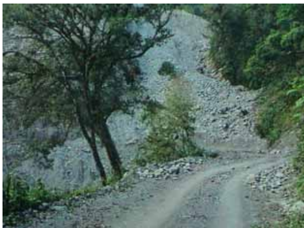
(Izq.) Camino Tlacuilotepec-Cuauतेpec: este tramo es uno de los más peligrosos de la región, el tipo de suelo arenoso provoca periódicamente fuertes deslaves que en varias ocasiones cierran definitivamente el paso. Es un tramo de 350 metros. (Der.) Camino Tlacuilotepec-Cuaxtla: el medio de transporte más común es el caballo y de carga el burro o la mula, es por ello que no es conveniente que los caminos se pavimenten, de forma que conserven su aspecto rural.
