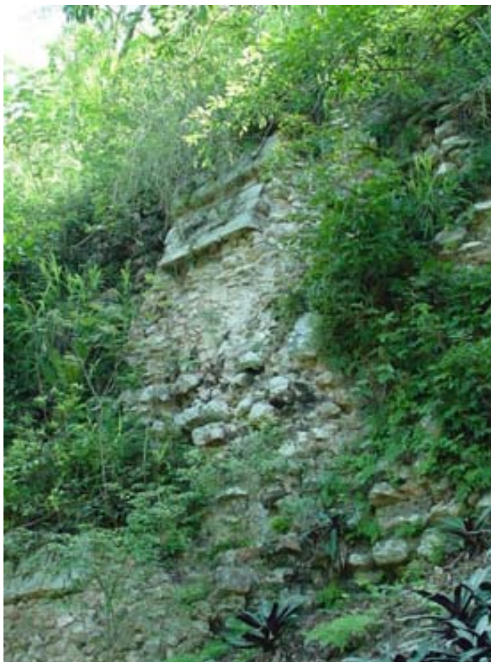
Ilustración 11.- Fachada posterior de la Estructura 2, foto del autor 2006.
