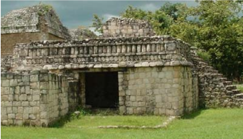
Ilustración 14.- Fachada norte de la Estructura 9, nótese el friso decorado con junquillos y las piedras inferiores en diagonal. Foto del autor 2006.
