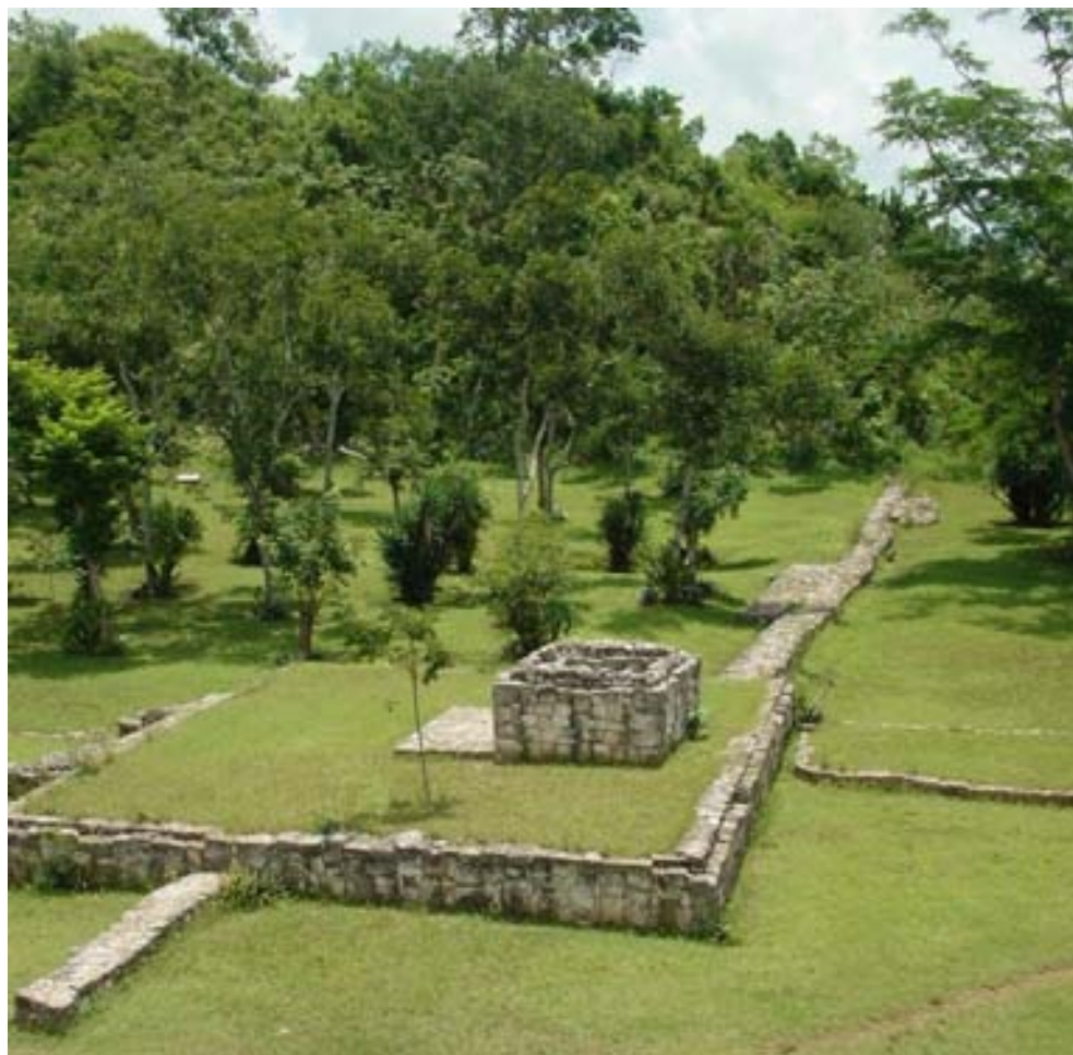
Ilustración 10.- Estructura 7, muestra en la parte superior de la imagen la pequeña muralla interna que separa las plazas norte a la izquierda y sur a la derecha; al fondo la muralla se une a la Estructura 3 no explorada aún. Foto del autor 2006.
