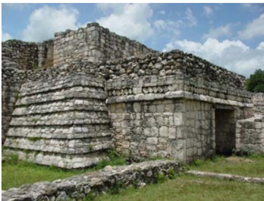
Ilustración 13.- Esquina noreste del Juego de Pelota, Estructura 8, nótese los 7 cuerpos volados en talud escalonado al lado izquierdo, y las piedras dispuestas en diagonal sobre el friso; asimismo se aprecia la muralla interna que se une a esta Estructura. Foto del autor 2006.
