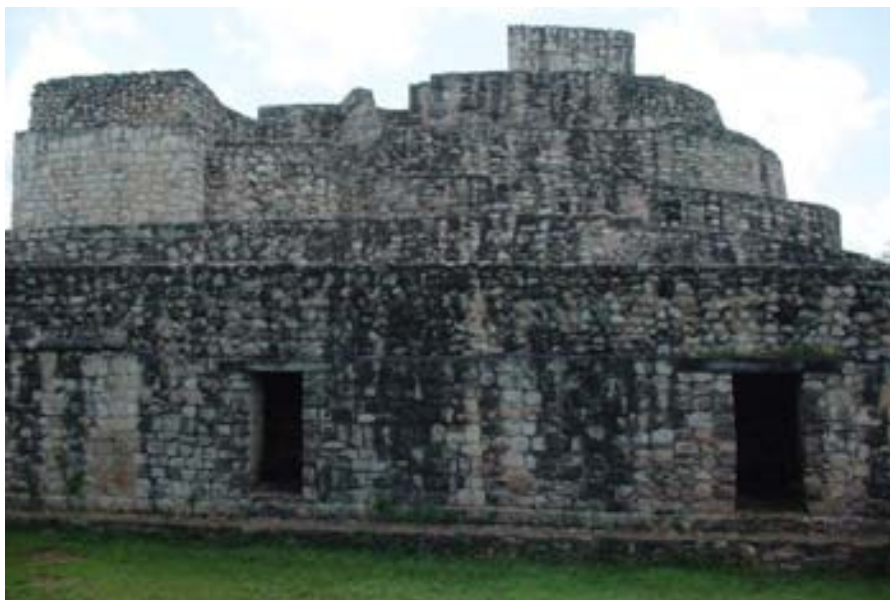
Ilustración 23.- Palacio Oval o Estructura 16, visto desde el oeste. Foto del autor 2006.
