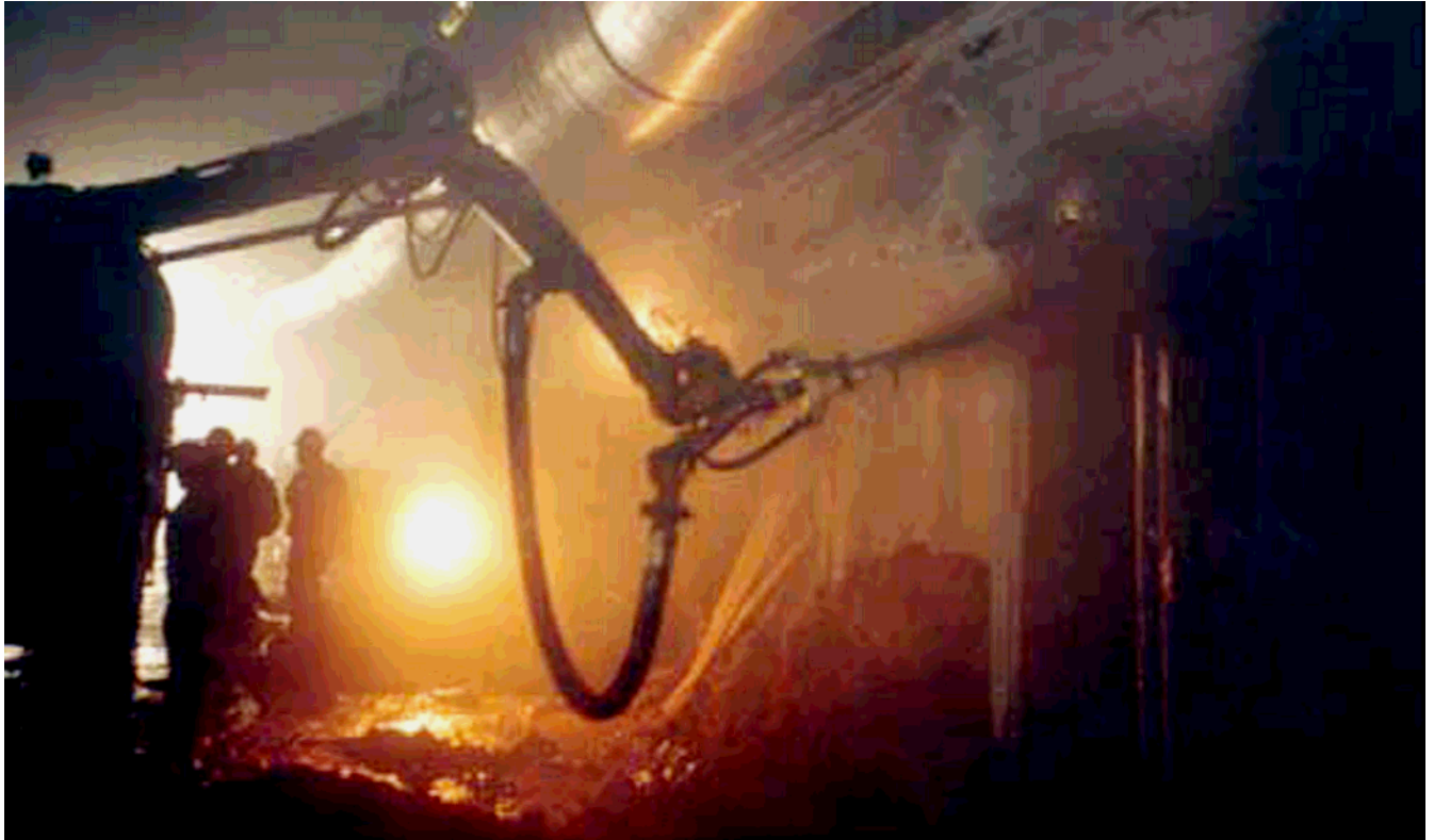
Foto. 5.19 En la fotografía vemos la aplicación de Concreto Lanzado con el equipo proyector de concreto en el interior del túnel
