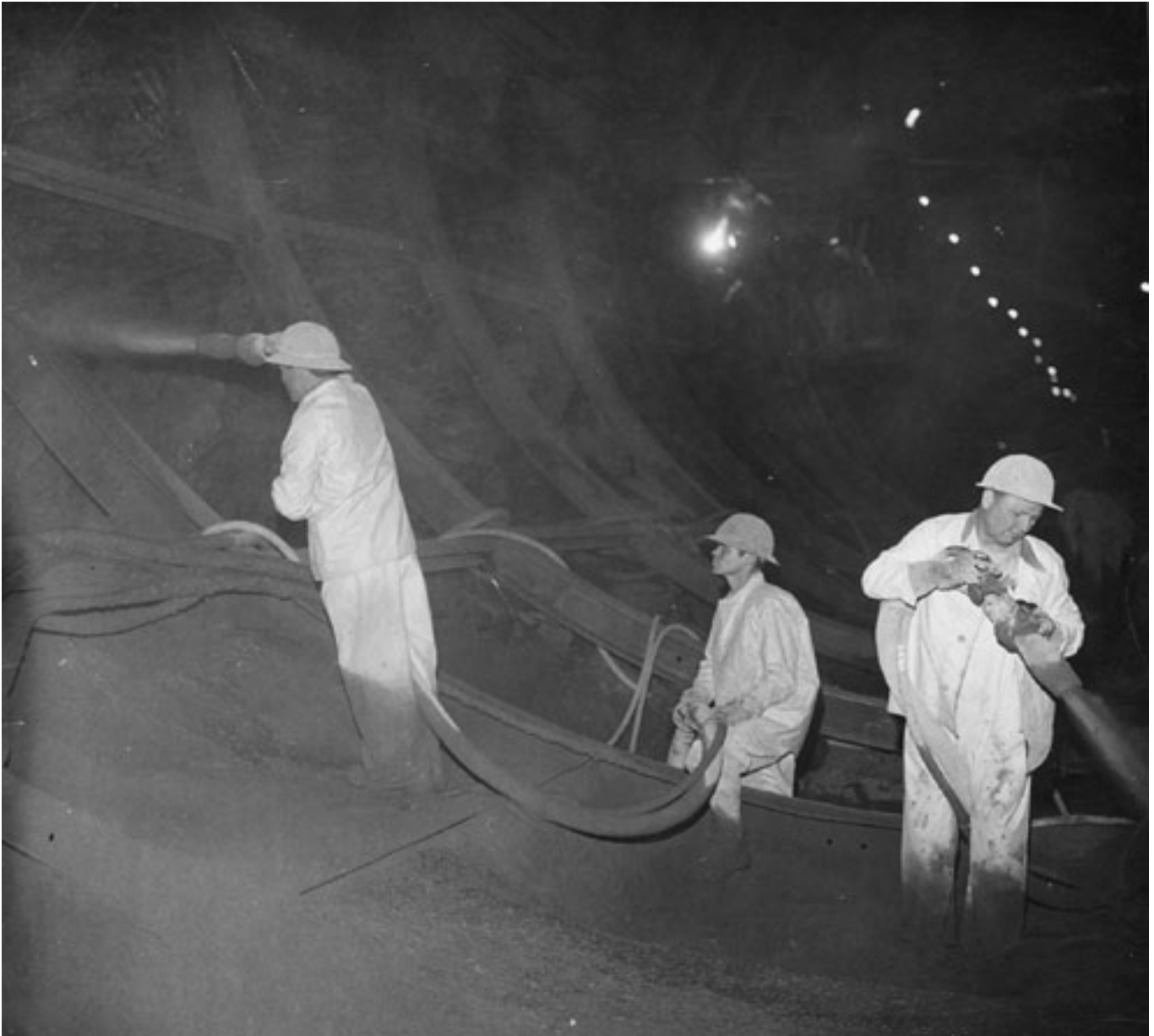
Foto. 6.4 Colocación del Concreto Lanzado con dos lanzadores uno lanzando en la pared del túnel donde se observa al ayudante y el otro colocando el concreto en el piso del mismo.
