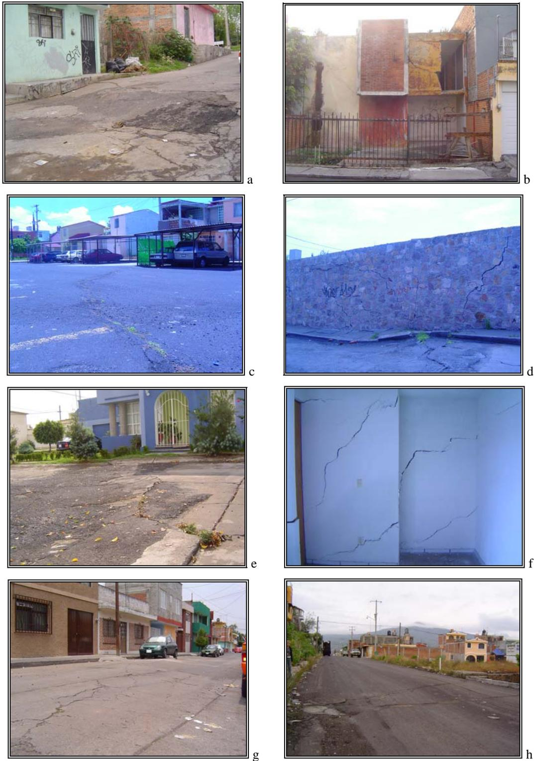
**Fig. I.2.** Daños que ocasionan las fallas en la superficie en la Ciudad de Morelia; a), b) Falla La Colina; c), d) Falla Central Camionera; e), f) Falla Torremolinos; g) Falla Cuautla; h) Falla El Realito.
