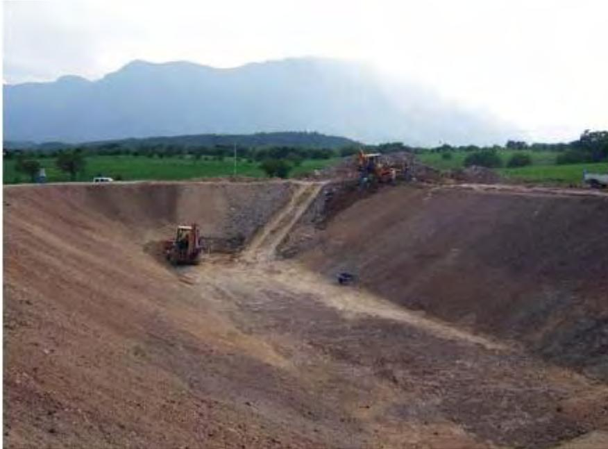
**FIGURA 3.8** Construcción Biodigestor .Fase: Excavación
