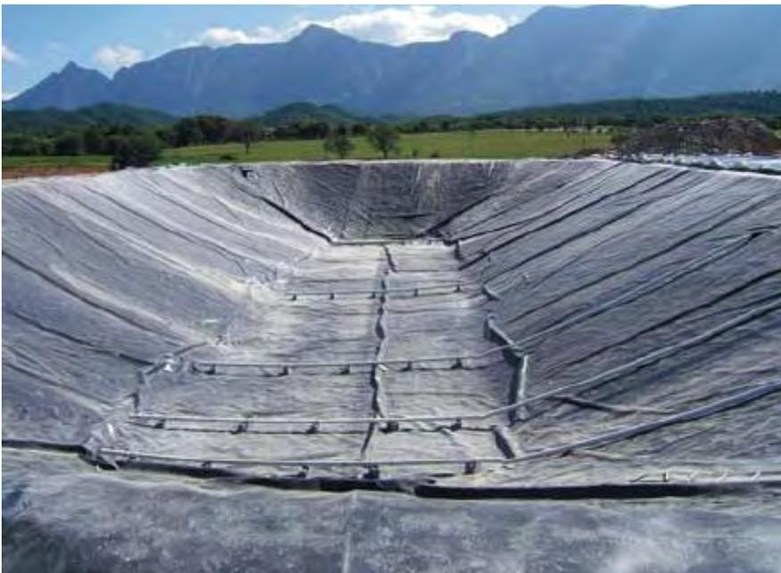
**FIGURA 3.9** Construcción Biodigestor. Fase: puesta del polietileno
