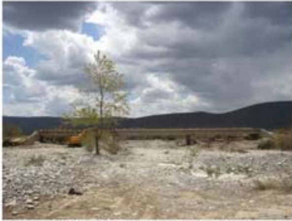
Fig. 58. El puente nuevo en El Nacimiento. Fotógrafo: Jesús Manuel Mager Hois, 2007.
