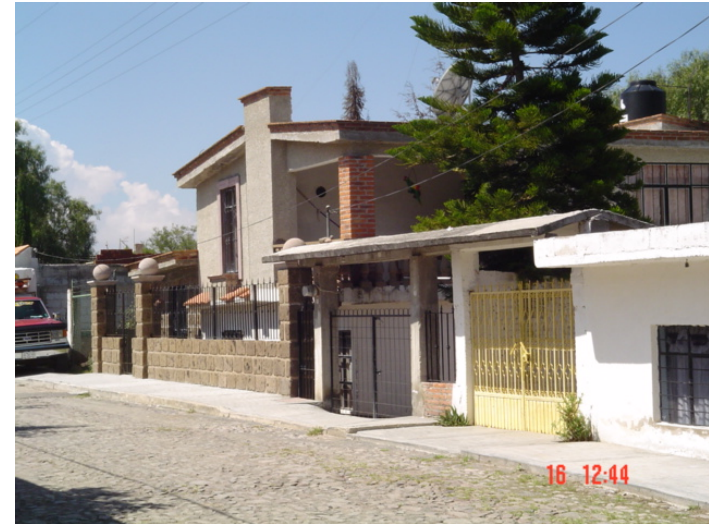
Materiales de la zona, se muestra algunas calles de la localidad de Paso de Mata, se deja el material aparente en otros casos se ocupa el aplanado.
