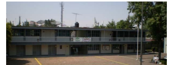
Edificio A Edificio administrativo
