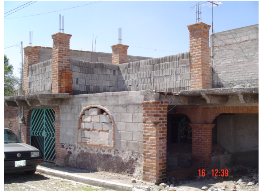
El sistema constructivo de la zona, castillos de concreto y revestidos de tabique rojo aparente y muros de tabicón; puertas de herrería pintada.
