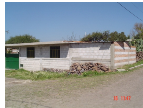
El sistema constructivo de la zona, columnas de concreto, muros combinados de tabicón y tabique rojo; estos materiales regularmente se dejan aparentes.
