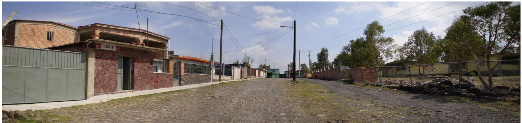
Calle Justo M. El material del arroyo vehicular es el empedrado y tiene un ancho de calle de 12 m, la banqueta de 1m de ancho; se percibe que predomina la casa habitación de un nivel y en algunos casos de dos niveles estas cuentan con los servicios municipales de; energía eléctrica, agua potable, drenaje y teléfono.
