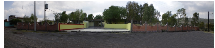
Calle Justo M. Se ubica el acceso principal de la Secundaria Técnica. Tiene el servicio de energía eléctrica, agua potable y drenaje.
