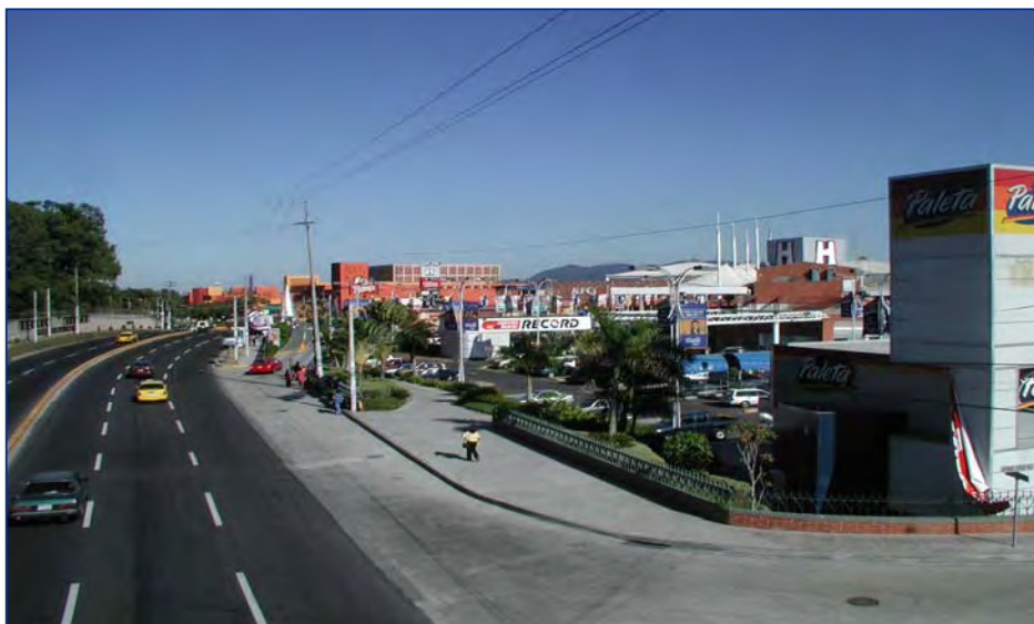
Fotografía 3. Carretera Panamericana (Frente a nuevos centros comerciales Antigua Cuscatlán)
