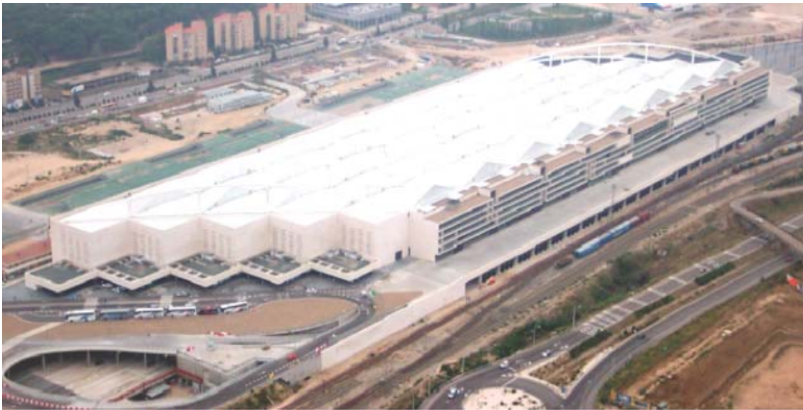
Figura 1.17 Vista exterior Estación Delicias
