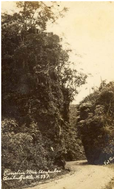
Figura 2.5. Carretera México-Acapulco tramo Acahuizotla Km. 33.7
