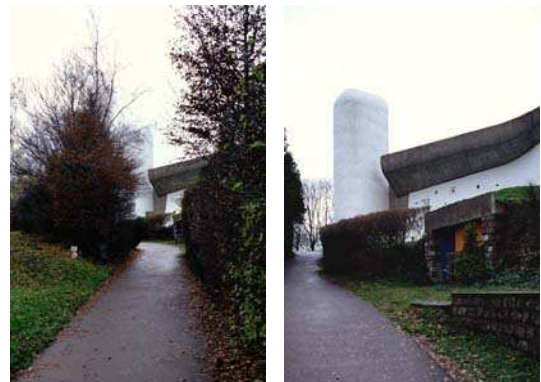
Acceso a la Capilla
