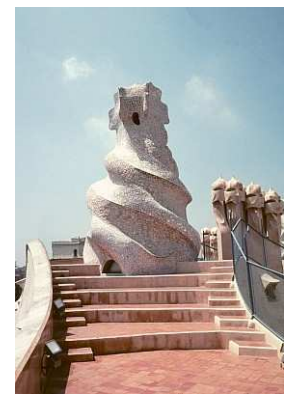
Detalle en azotea
