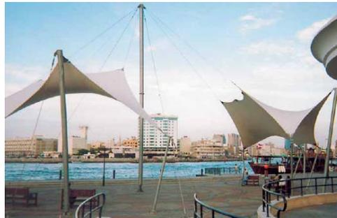
**Figura 2.16. Red de cables con diversos puntos altos**
