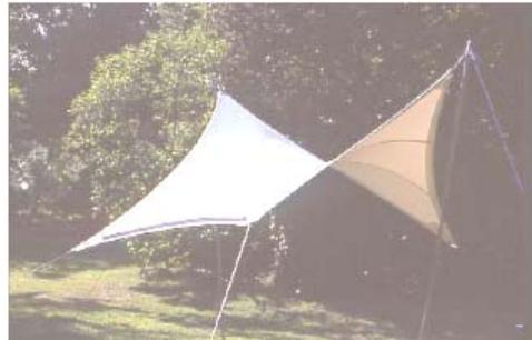
Figura 2.4. Membrana de curva pretensada con varios apoyos
