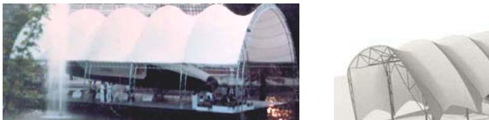
**Figura 2.10. Red de cables entre arcos verticales**
