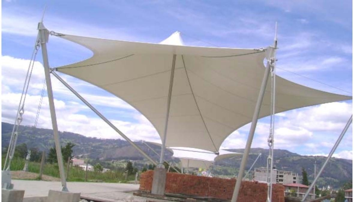
**Figura B.12. Velaria con varios puntos de apoyo**
