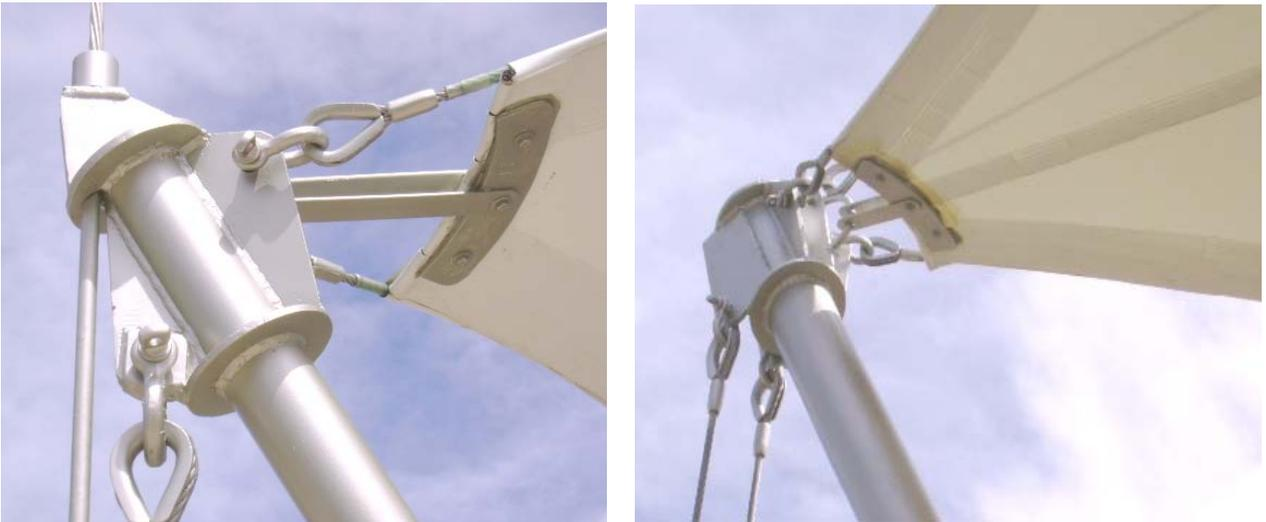
**Figura B.15.** Conexiones entre apoyos, cables y cubierta textil
