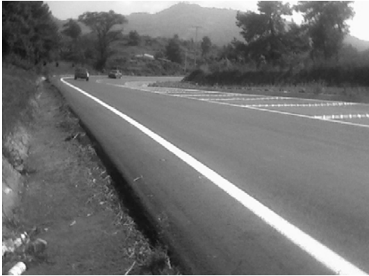
Imagen 24- Km. 65+500, entrada a curva y cunetas Fuente: Propia.
