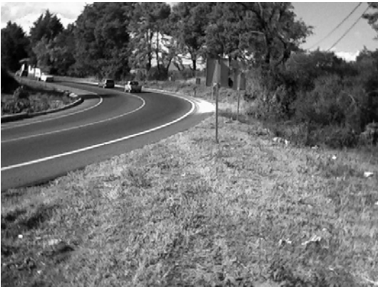
Imagen 30- km. 65+750.31, sobre elevación en curva Fuente: Propia.
