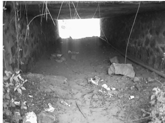
Imagen 31- km. 65+750.31, alcantarilla Fuente: Propia.
