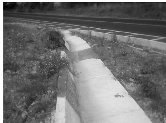
Imagen 27- Cuneta Fuente: Propia.
