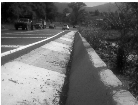
Imagen 26- cuneta Fuente: Propia.
