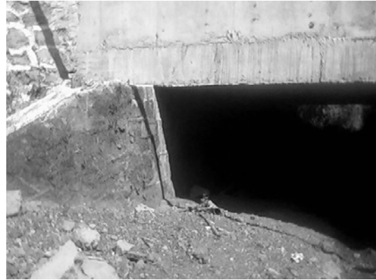
Imagen 29- km. 65.750+31, alcantarilla, muros de contención tipo A y muro tipo B Fuente: Propia.
