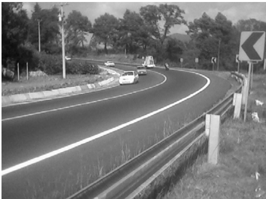
Imagen 25- Km. 65+800, entrada a curva, cunetas y sobre elevación en curva Fuente: Propia.
