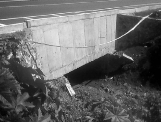
Imagen 28- km. 65+750.31, alcantarilla, muros de contención tipo A y muro tipo B Fuente: Propia.
