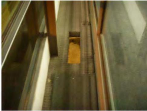
*Imagen 23. Aberturas improvisadas en el corredor entre muros de las fachadas dobles.*
