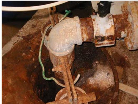
Estado físico del tren de descarga que presentaba el pozo de Janitzio
